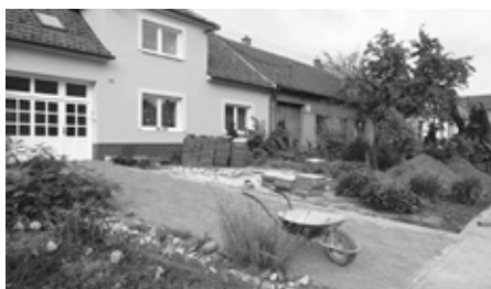
Kromě předzahrádek prošlo generální opravou na ulici Dlouhá i několik nájezdů k rodinným domům.
