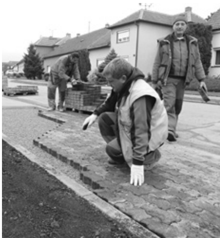
Horní část ulice Dlouhá – budování parkovacích míst.
