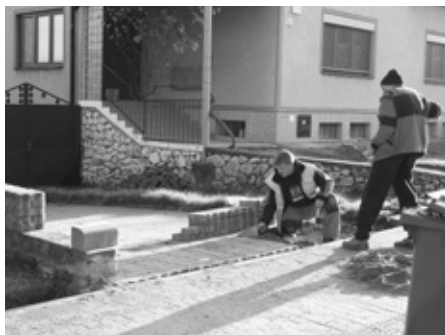
Úpravy nájezdů k rodinným domům v ulici Pod Břehy.
