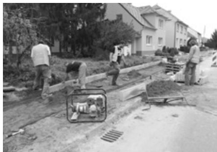
Ulice Pod Břehy – pokládání obrubníků k novému chodníku.
