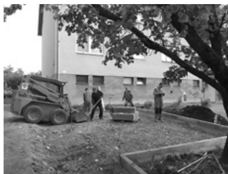
Zahájení budování parkoviště u bytových domů na ulici Bří Mrštíků.
