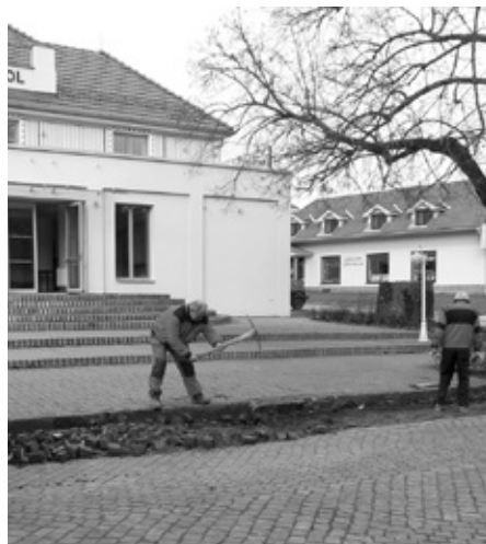
Úpravy prostranství před vstupem do rekonstruované sokolovny.
