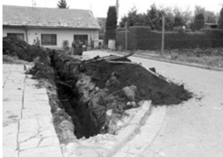
Hloubení výkopů pro položení elektrického vedení veřejného osvětlení, Tovární čtvrt.
