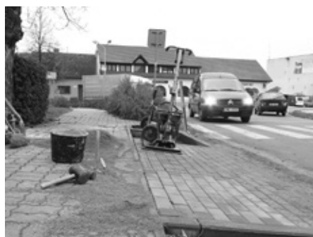
Bezbariérové vstupy k budoucímu přechodu pro chodce.
